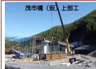
⑧施工：日本ファブテック(株)
