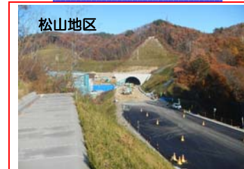
③施工：鹿島道路(株)
