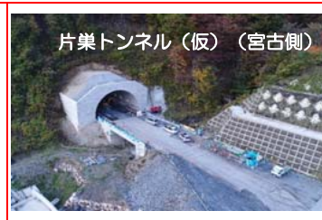
⑰施工：(株)奥村組
